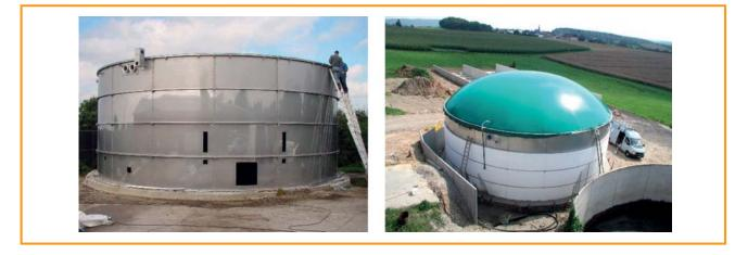
Figure 3.30: A special-steel digester under construction [Anlagen- und Apparatebau Lüthe GmbH]
